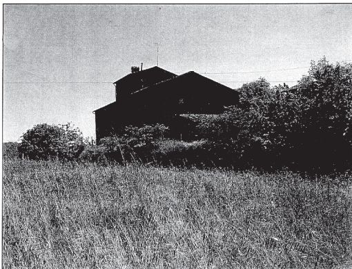
Foto 3 – Haus an der Abzweigung Hauptstraße MONTE SAN SAVINO – SAN PANCRAZIO / S 113 aus Richtung MONTE SAN SAVINO (Mai 2004)
