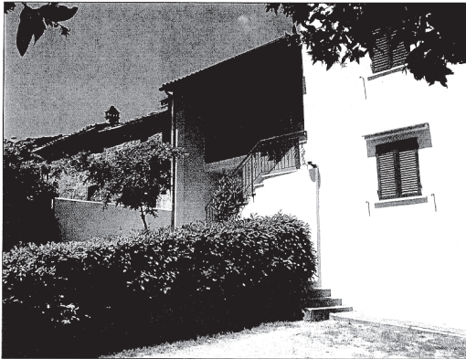
Foto 11 – Blick auf den gesamten Gebäudekomplex PODERE MORCAGGIOLO (Mai 2004)
