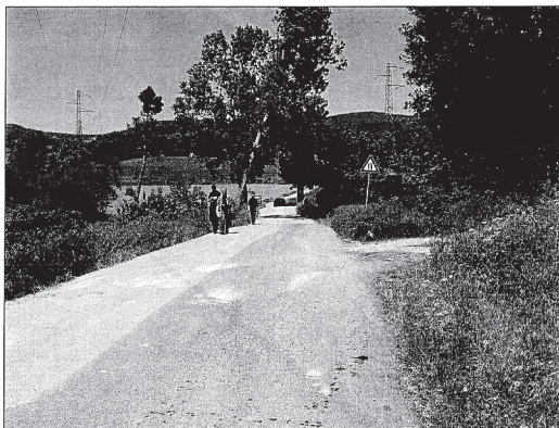
Foto 4 – S 113 aus Richtung Hauptstraße MONTE SAN SAVINO – SAN PANCRAZIO in Richtung ESSE-BRÜCKE (Mai 2004)
